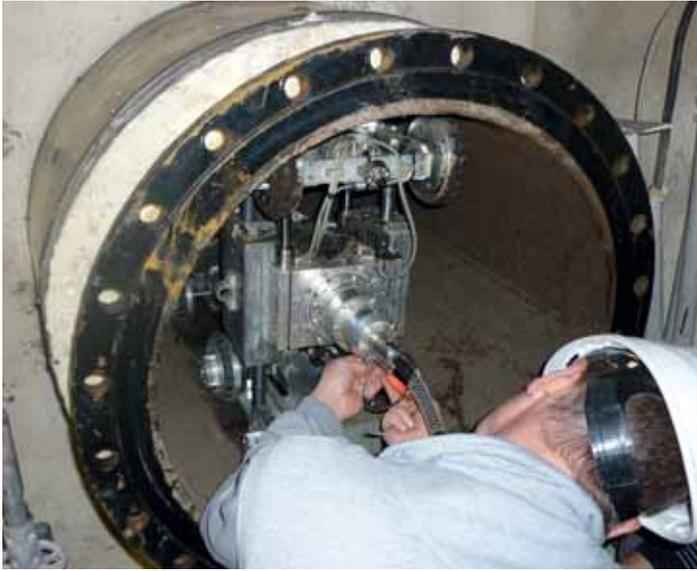
Mit den Rohrrobotern von INSPECTOR SYSTEMS wurde 2010 im Rahmen der routinemäßigen Jahresrevisionen in zwei deutschen Kernkraftwerken erstmals die Innenbeschichtung an verschiedenen erdverlegten Kühlwasserrohrleitungen der VE-Systeme vollflä-
